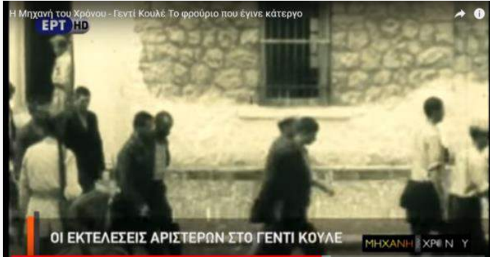
Η μεταφορά φυλακισμένων με συνοδεία φρουράς στον χώρο θανάτωσης
